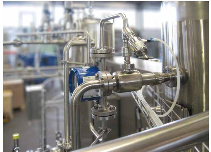
Feineinstellung für die CO<sub>2</sub>-Zugabe von 0–2 g/l mit Karbonisierereinheit.
